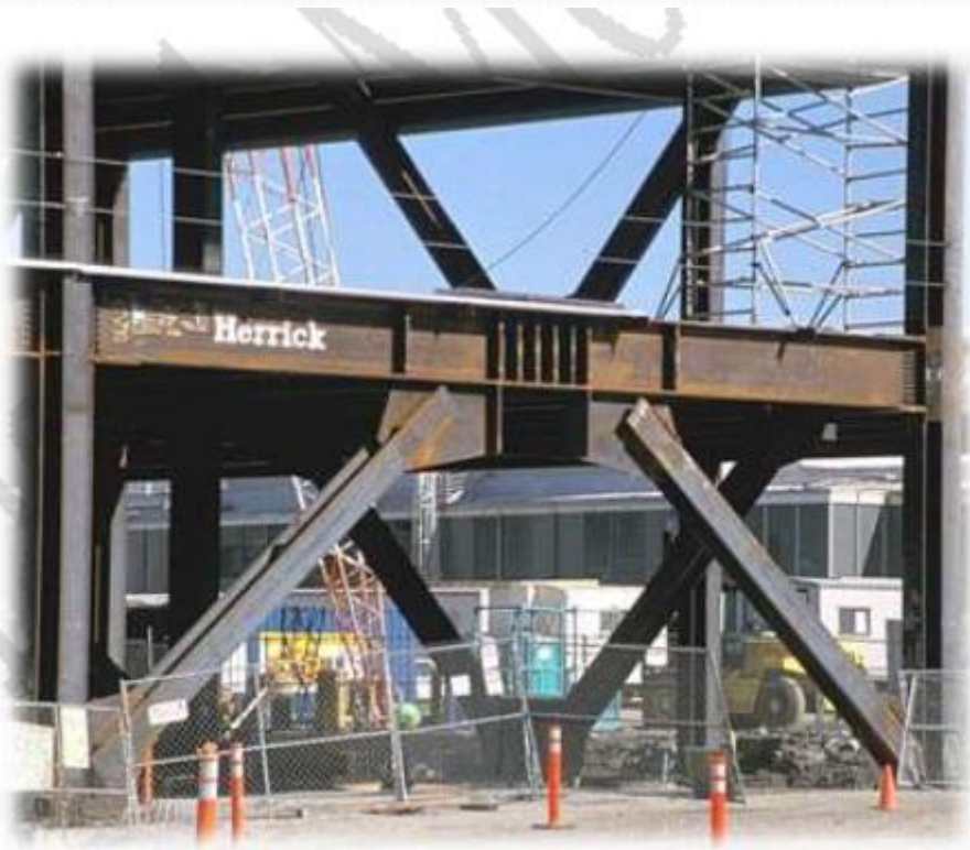
شکل ۶-۷ نمونه ای از قاب مهاربندی برون محور اجرا شده [12]
